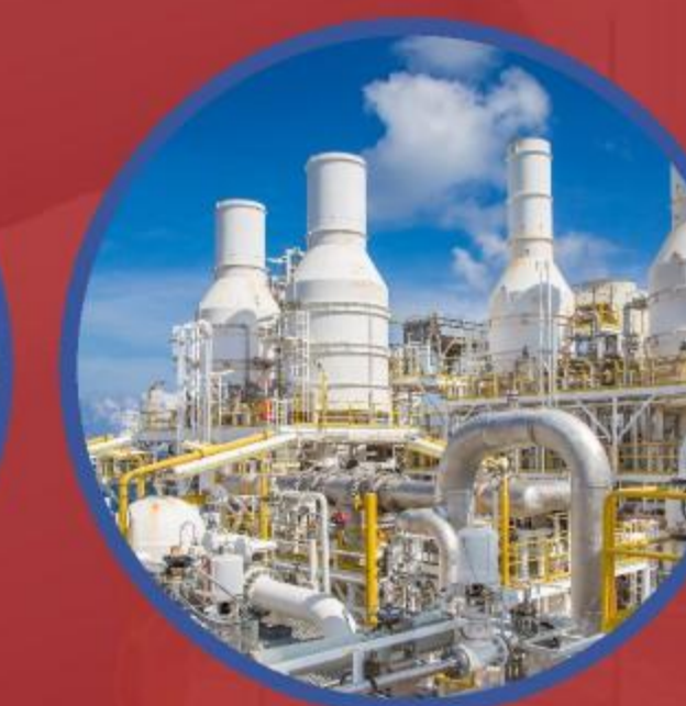
天然气 NATURAL GAS
